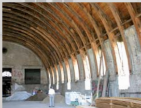
Inspektion der Sanierung des Marstalls von F.A. Stüler in Basedow
