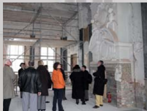
Besichtigung der Restaurierungsarbeiten in Schloss Mirow
